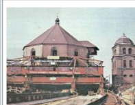
Obrázek 2 Kostel připravený k přesunu
