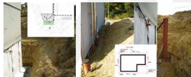
Schéma a realizace osazení kontrolních šachtic Scheme and built shaft pipes
