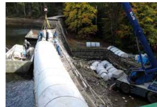
Ukládání kame-nořezů na přeliv zděné hráze vodního díla Naděje Placing of semi-circular stones onto the spillway of a bricked dam of the Naděje Waterwork.
