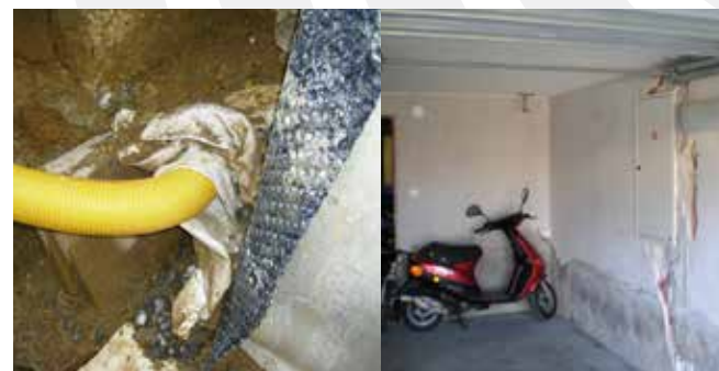
Vlevo je nevhodné umístění obvodového drenážního potrubí nad úroveň vodorovné hydroizolace. Vpravo jsou důsledky v podobě silně vlhkého zdiva suterénu Installations of site drainage. Left – inappropriate position of a perimeter drainage pipe above horizontal systematic drainage. Right – resultant very damp basement masonry.
