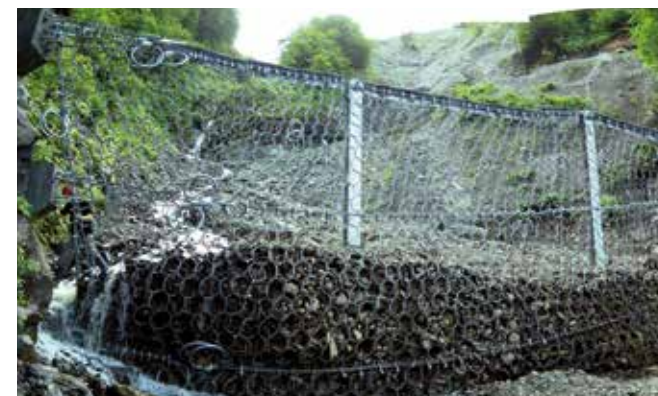
Ukázka funkce bariéry a jejího přetvoření při zachycení splavenin (dynamická bariéra UF 180 H6) Example of the barrier's function and its deformation when catching sediment runoff (dynamic barrier UF 180 H6).
