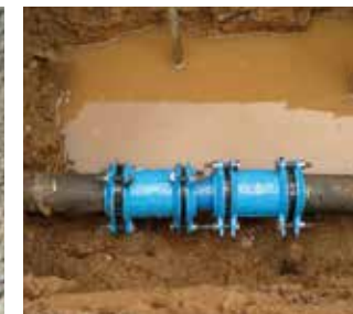
Ukázka způsobu opravy poruchy řad DN150 na ul. Zahradní v Hlučíně Example of a repaired failure of a main DN150 in Zahradní street in Hlučín, the Czech Republic
