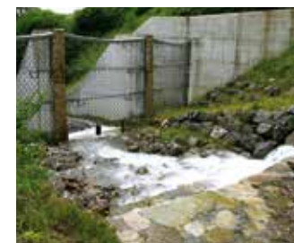
UX bariéra se dvěma opěrami, konstrukční výška kruhových sítí 6 m (Švýcarsko), lana jsou ochráněna kmeny stromů UX barrier with two retaining walls; the structural height of circular nets is 6 meters (the Swiss system); cables are protected by trunks.
