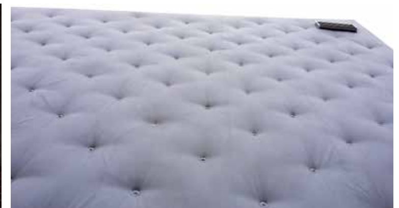
Detail finálního provedení čalouněné fasády – Centrum moderního umění NEW DOX, Praha Detail of the final upholstered façade – the extension of the Center for Modern Art, Prague, the Czech Republic
