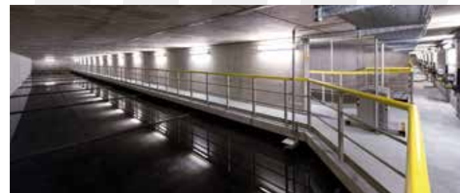
Dosazovací nádrže Secondary settlement tanks
