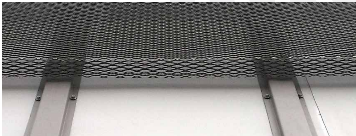
Povlaková hydroizolace pod dekorativním obkladem fasády – obchodní středisko v Českých Budějovicích Damp proof coat under a decorative veneer façade – a shopping mall in České Budějovice, the Czech Republic
