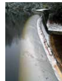
Pohled na přeliv po dokončení rekonstrukce; voda stabilně přetéká přes přelivnou hranu View to the spillway after the renovation; water flows continuously over the crest of the weir.
