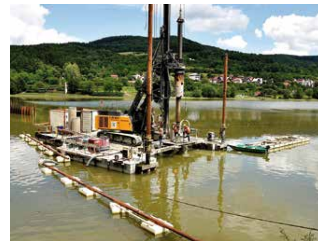
Beranění pilot pro založení železničního mostu – Zátka a Šperger, Zakládání staveb, 2019, Praha Pile driving for the railway bridge pier foundation – Zátka and Šperger, Zakládání staveb company, Prague, 2019.
