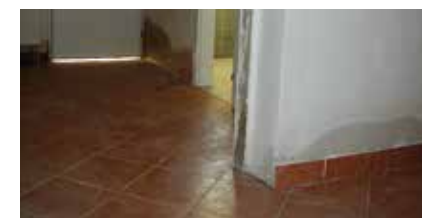
Důsledky chybného výškového osazení objektu na pozemku – dešťová voda natekla na vodorovnou hydroizolaci Effects of poor vertical positioning of the building on the site – rainwater leaked below the damp proofing course
