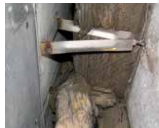
Tepelné izolace působením vody pronikající obkladem zdegradovala a odklonila se od stěny směrem k obkladu – Archiv hl. m. Prahy Thermal insulation degraded due to water leaking behind the veneer and deflected away from the wall towards the veneer – The Prague City Archives, the Czech Republic.
