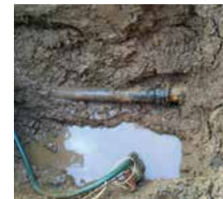
Ukázka poruchy na vodovodním řadu DN150 na ul. Zahradní v Hlučíně Example of a failed water main DN150 in Zahradní street in Hlučín, the Czech Republic
