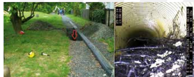
Prorůstání trubkové drenáže kořeny stromu a keřů rostoucích cca 2 m od drenážní roviny. Vpravo je pohled kamerou do potrubí, jehož poloha je označena šipkou Roots of trees and shrubs growing approximately 2 meters away from the drainage plane, penetrating through the tubular drainage. Right: a camera view into the pipe marked with the red arrow in the right-hand photo.
