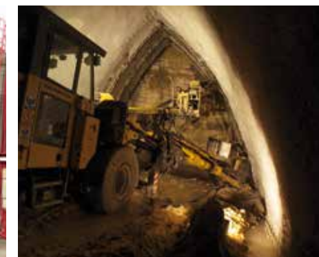
Prodloužení metra trasa A – přímá interakce s vodou – archiv Metrostav, Praha Extension of the Metro line A – direct interaction with water – Metrostav archives, Prague, the Czech Republic
