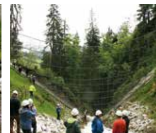
Flexibilní VX bariéra na toku Hüpach v kantonu Bern, retenční prostor pro zadržení 16 000 m³ splavenin, konstrukční výška bariéry 20 m, nosná lana zavěšována pomocí helikoptéry Debris flow VX barrier for the Hüpach stream in the Canton of Bern; catchment space for the retention of 16,000 m³ of sediment runoff; the barrier's structural height is 20 m; a helicopter is used to hang loadbearing cables.
