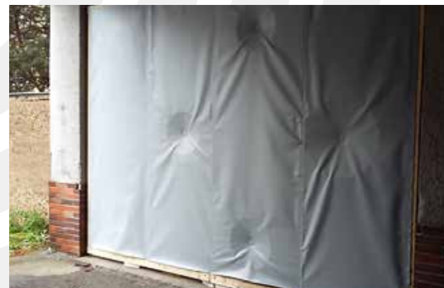
První pokusný vzorek provedení čalouněné fasády – Centrum moderního umění NEW DOX, Praha The first sample of the upholstered façade – the extension of the Center for Modern Art, Prague, the Czech Republic
