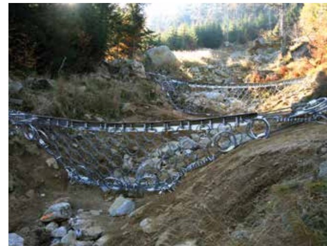
Vybudované flexibilní bariéry GEOBRUGG VX na svahu Smědávské hory v CHKO Jizerské hory (první instalace bariér v rámci ČR) Debris flow barriers GEOBRUGG VX built in slopes of the Smědávská hora (Mountain) in the Jizerské hory (Jizera Mountains) Protected Landscape Area (the first installation of such barriers in the Czech Republic).
