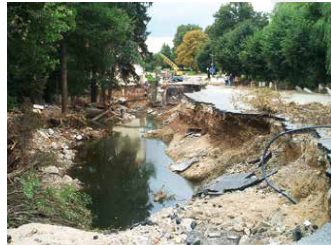
Porušení silnice E 49, vedoucí přes hráz historického rybníka, při povodních v roce 2002 Damaged road E 49 crossing the crest of the small historical dam due to overflowing during floods in 2002
