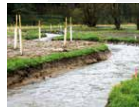
Nové koryto VT Halštrov s provedenou novou výsadbou doprovodné vegetace, dodatečné zpevnění břehů kořeny stromů A new basin of the Halštrov creek with new green plantation; creek banks additionally fixed with roots of trees.
