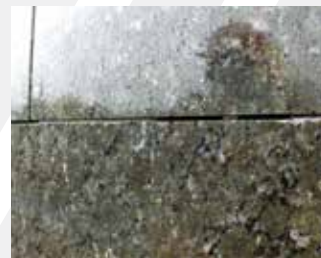
Voda ve spáře zavěšeného fasádního obkladu z kamenných desek – administrativní objekt v Olomouci Water in the joint of a stone veneer façade – an office building in Olomouc, the Czech Republic
