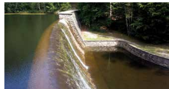
Původní přeliv tělesa hráze před rekonstrukcí The original dam's spillway before the renovation
