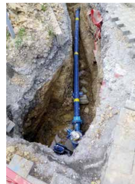
Oprava poruchového vodovodního řadu DN100 na ul. Rovniny v Hlučíně Repaired water main DN100: Rovniny street in Hlučín, the Czech Republic
