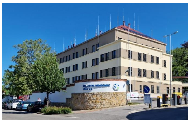
Novostavba pavilonu „A“ Oblastní nemocnice Jičín
