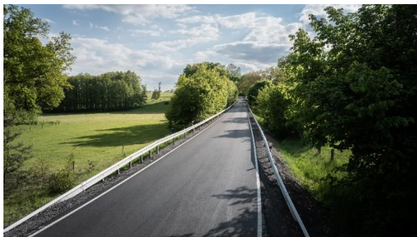
III/3051 Albrechtice nad Orlicí II. ETAPA
