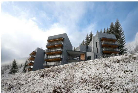
Pec pod Sněžkou Apartmány Hnědý vrch rekonstrukce č.p. 52
