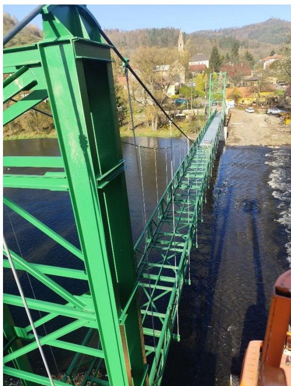
Obr. 9 - rekonstrukce lávky-pohled z dronu na osazování plechů mostovky
