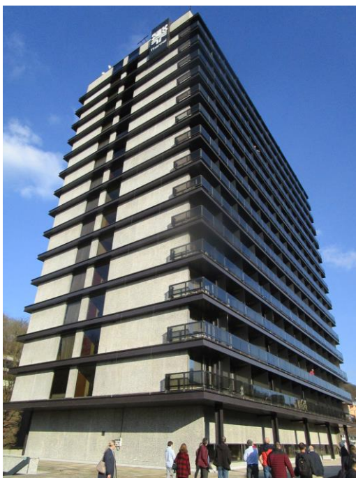
Pohled na zrekonstruovanou fasádu hotelu
