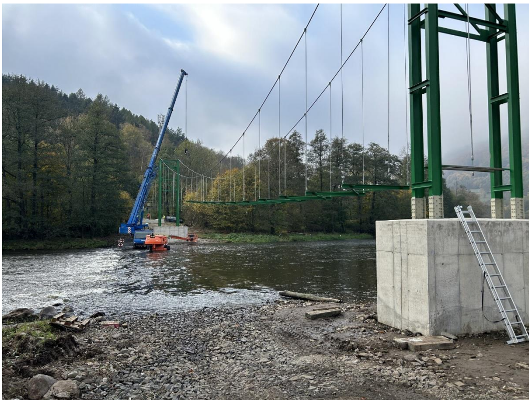
Obr. 6 - rekonstrukce lávky-osazování příčníků
