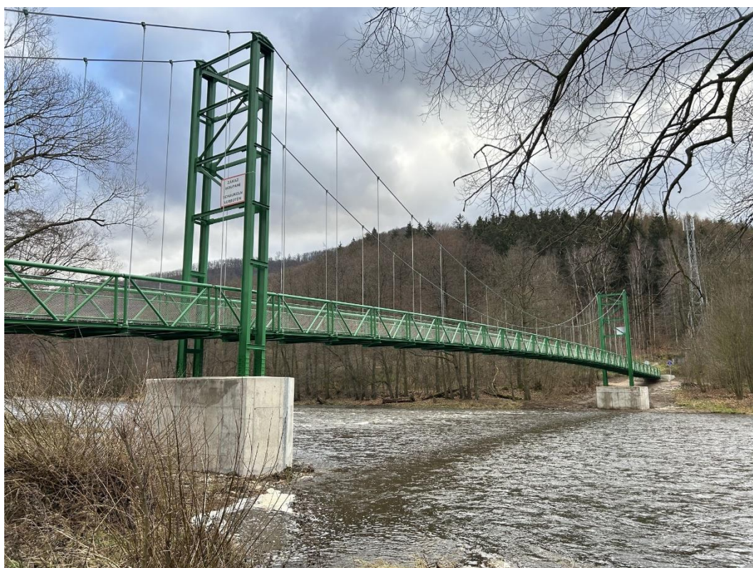
Obr. 11 - lávka po rekonstrukci
