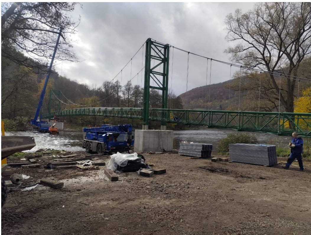
Obr. 7 - rekonstrukce lávky-osazení plechů mostovky
