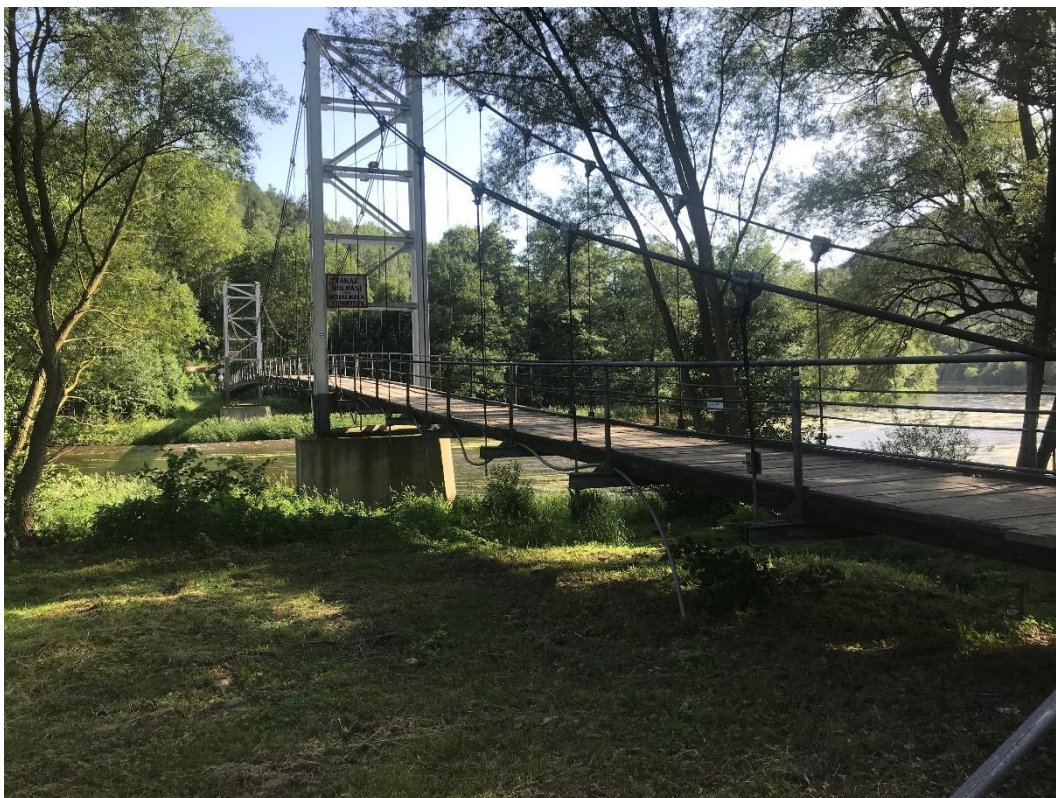
Obr. 4 - lávka v roce 2021
