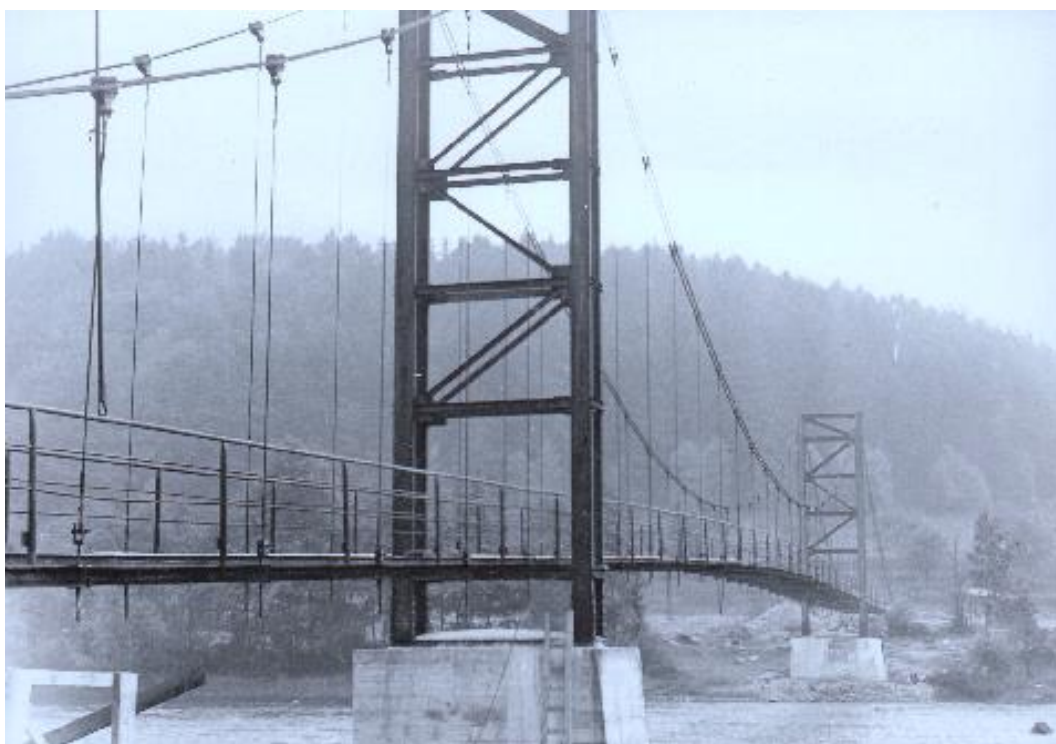
Obr. 2 - Původní lávka-fotka po dokončení stavby
