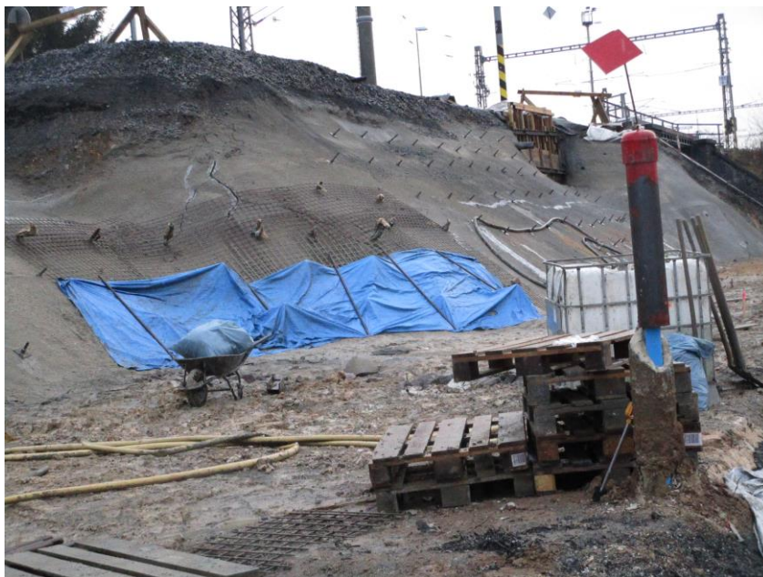
8 Sesuv tratě v KV - monitorovacím vrtem se sleduje výška hladiny podzemní vody
