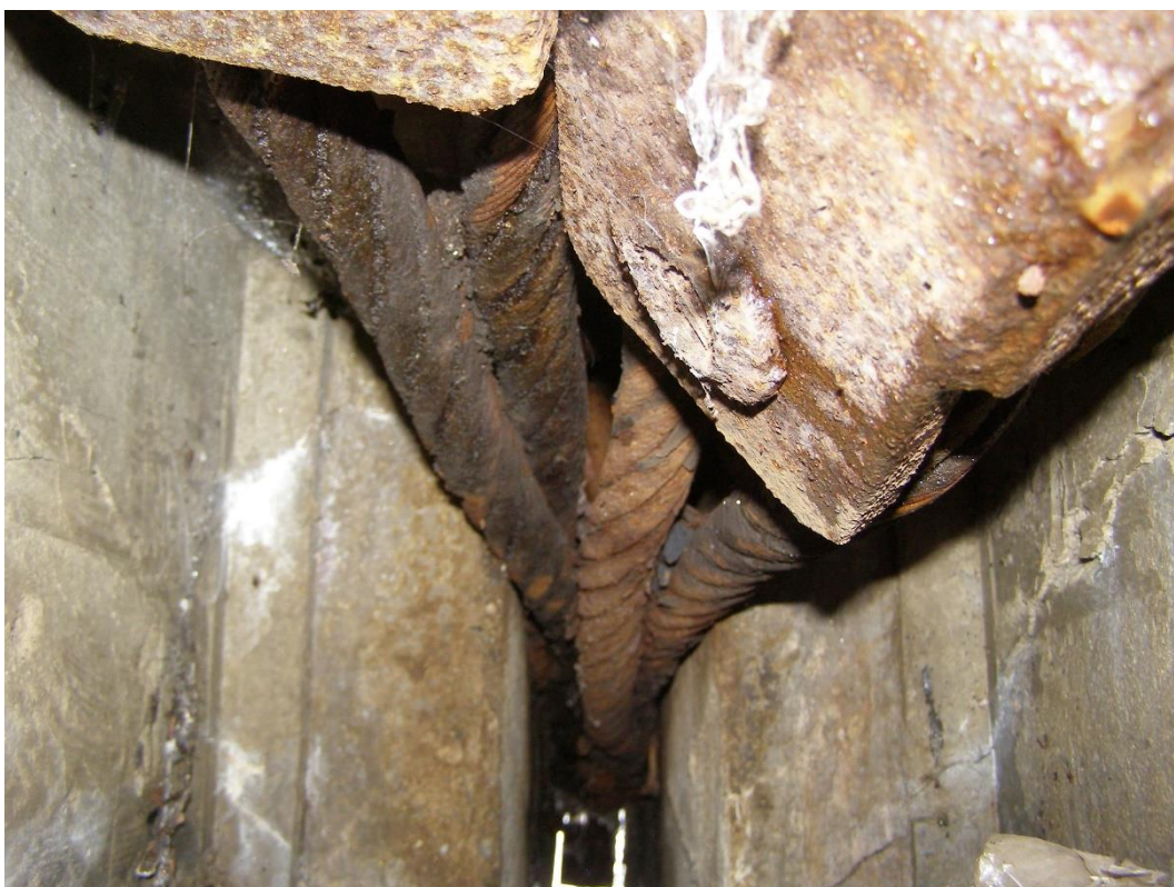
Obr. 5 - lana původní lávky v místě kotvení
