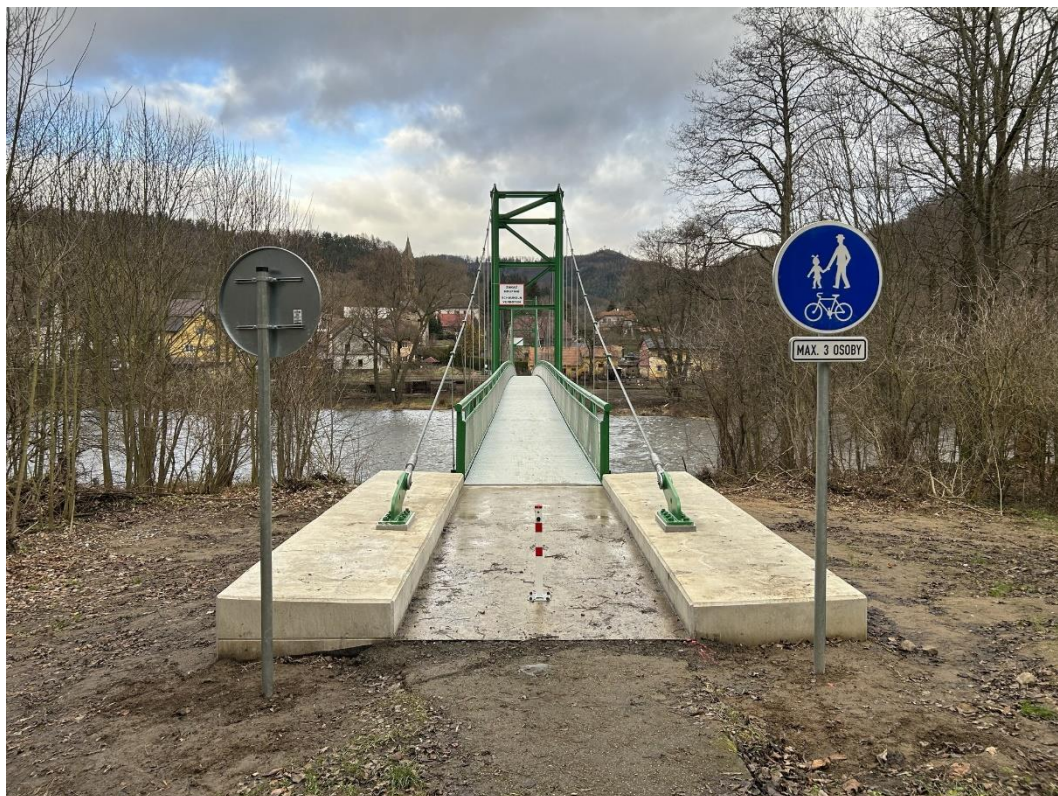
Obr. 10 - lávka po rekonstrukci
