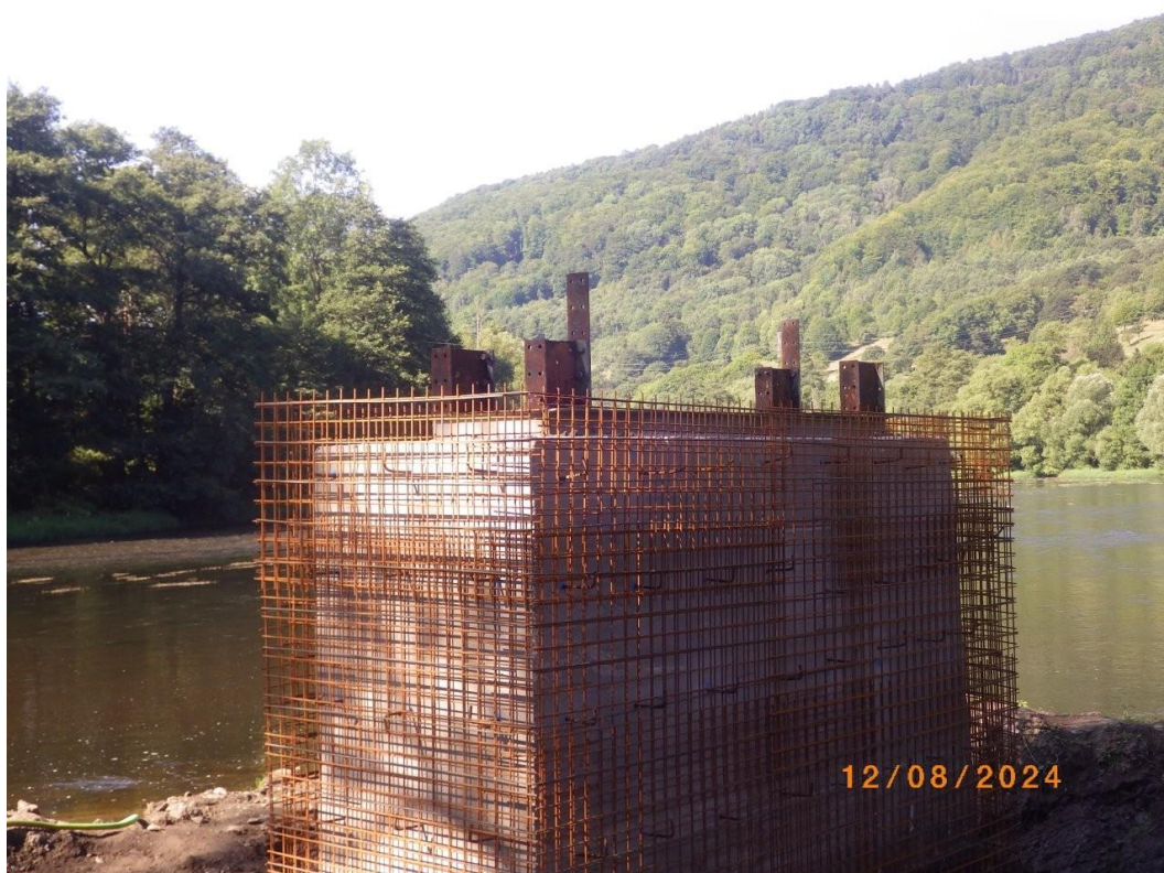
Obr. 8 - rekonstrukce lávky-opláštění dřívku pylonu-výztuž
