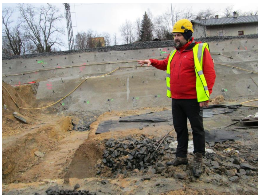
7 Sesuv tratě v KV - odvodňovací žebro a Ing. Jan Ďurove
