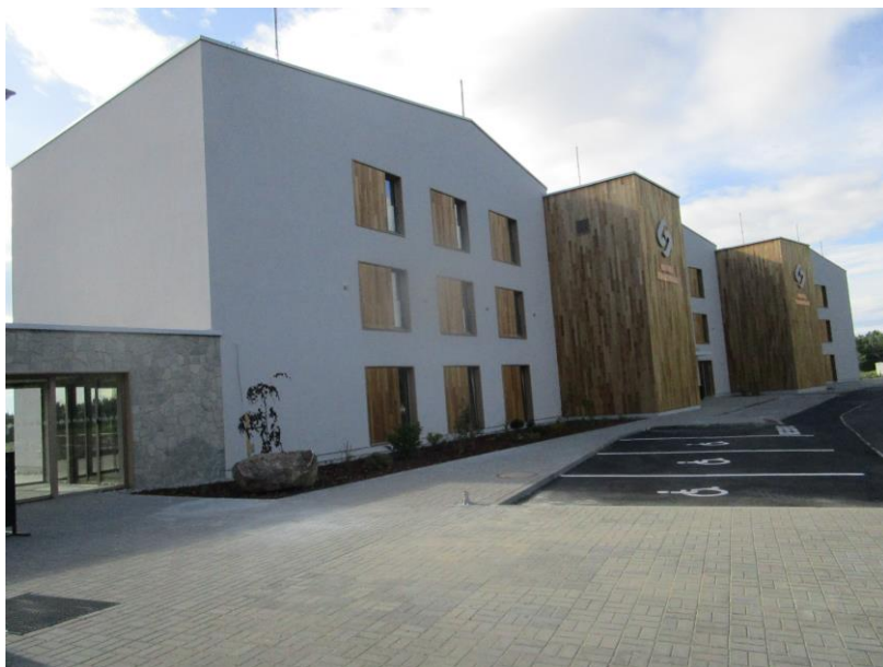
Hotel Marshall Golf & Wellness Hotel v Sokolově – celkový pohled
