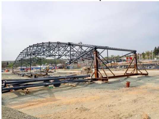
Ocelová střešní konstrukce před montáží
