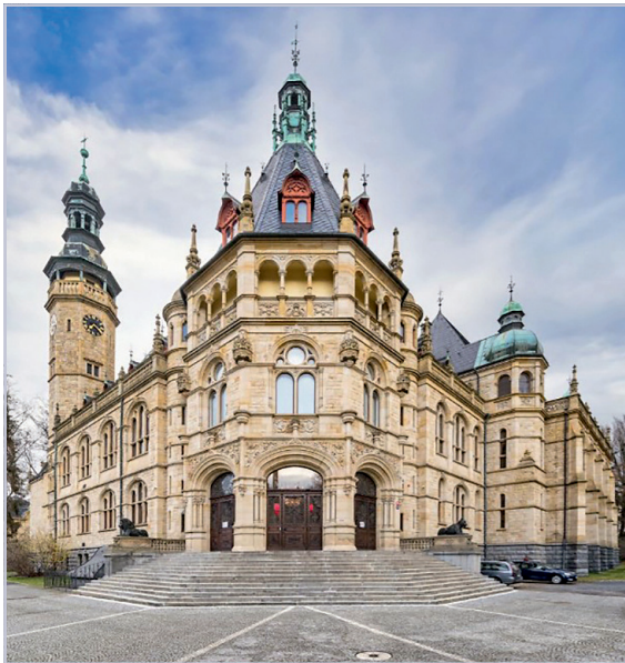
Modernizace hlavní budovy Severočeského muzea v Liberci (SRLK 2021)
