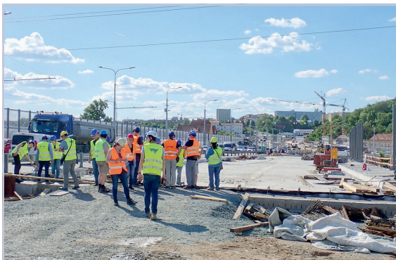
Fotografie z exkurze OP Brno na stavbu Tomkova náměstí (2024)
