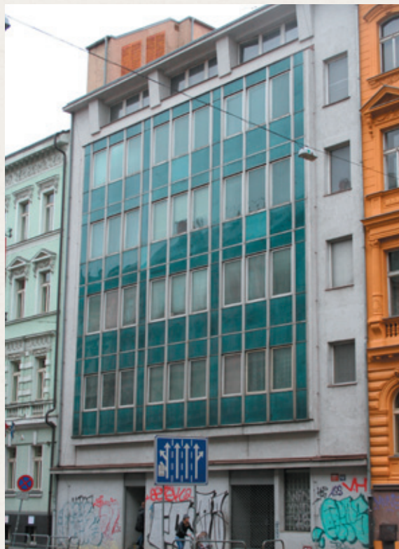
Budova v Legerově ulici v Praze 2, původní sídlo ČSSI
