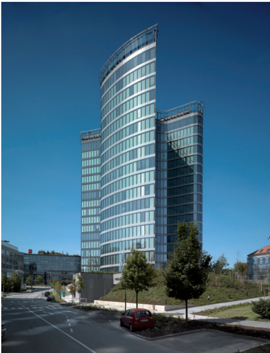
Budova FILADALFIE, BB Centrum, Praha
