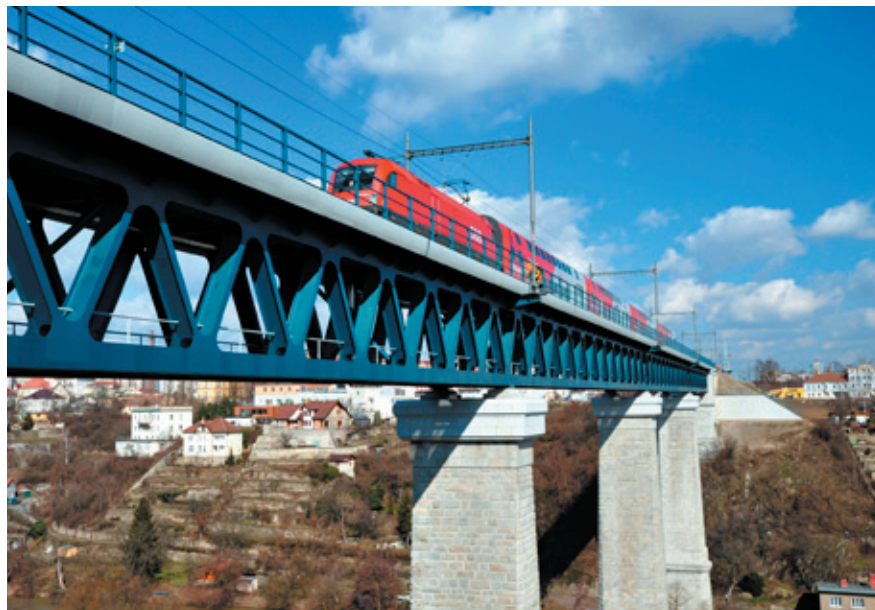
Železniční most nad řekou Dyje, Znojmo
