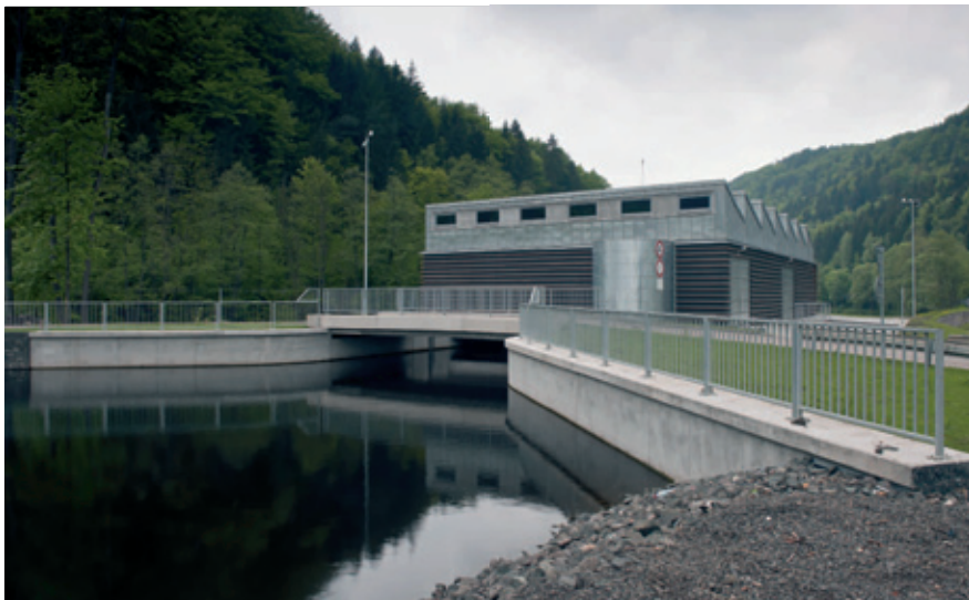
Malá vodní elektrárna, Železný brod – krajinně působivé řešení stavby na obnoveném náhonu
