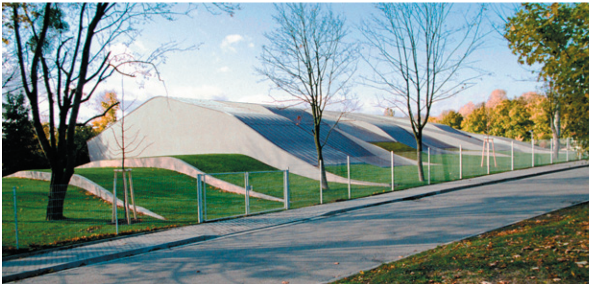
Krytý plavecký bazén v Litomyšli
