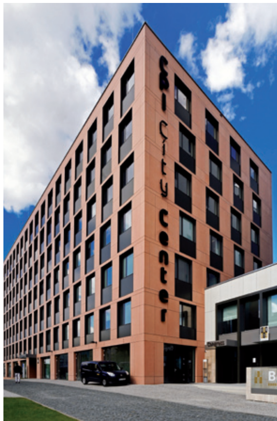
Multifunkční komplex CPI City Center, Olomouc
