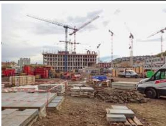
Obr. 5 Staveniště Smíchov City
