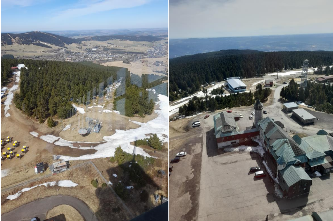
Pohled na okolí Klínovce z technologického podlaží na vrcholu věže
